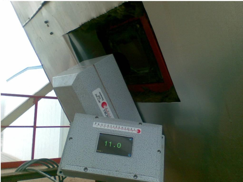
图 10. 探头垂直于玻璃表面安装
